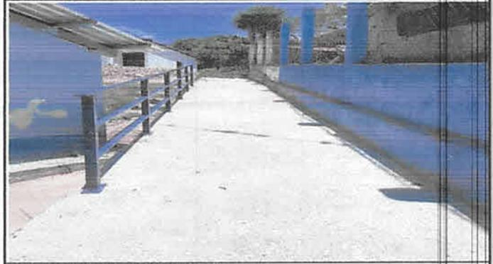
Foto 8: reparación de gradas por rampa
