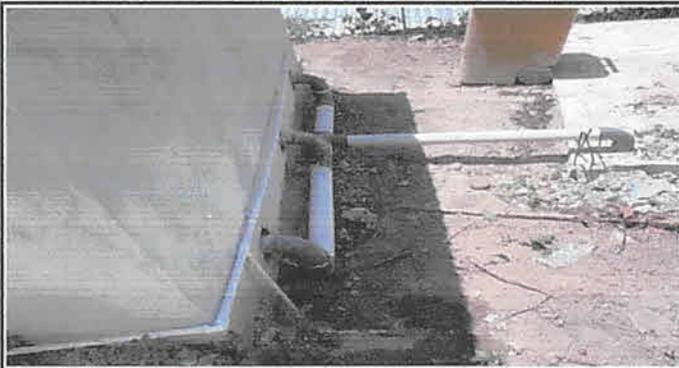
Foto 9: conexión de fosa séptica con pozo de absorción anexo
