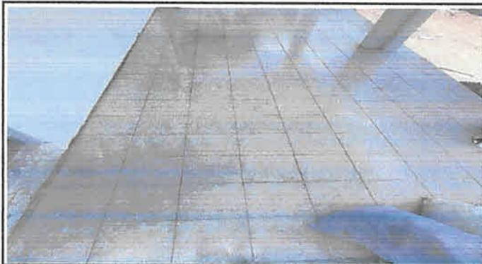
Foto 3: sustitución de torta de cemento por piso cerámico
